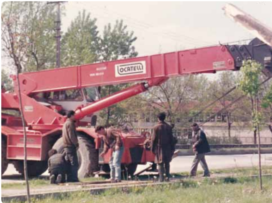
■ Der Kran wird vorbereitet
