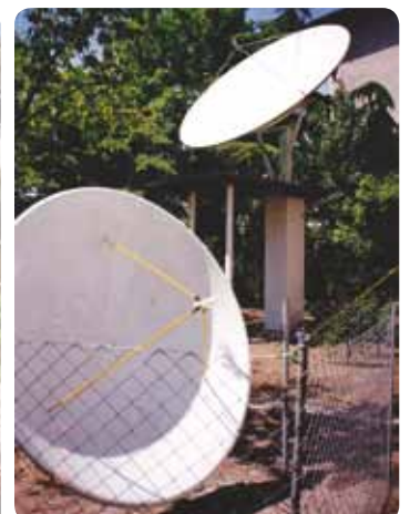
■ Im Vordergrund der kleine 1.50m Spiegel, mit dem Cahit heute den ASTRA 2 auf 28.2 Ost empfängt.
