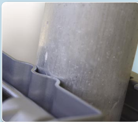
Marke, um den Drehmotor am Mast auf Süd auszurichten
