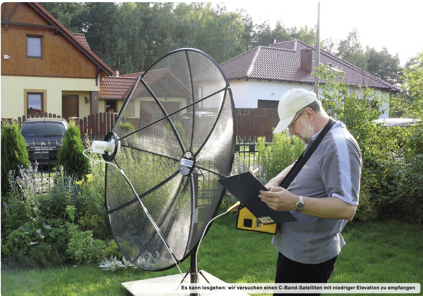
Es ist Zeit die Antenne auszurichten. Wir empfehlen die Zuhilfenahme einer Wasserwaage mit eingebautem Winkelmesser – damit wird die Arbeit enorm erleichtert.
