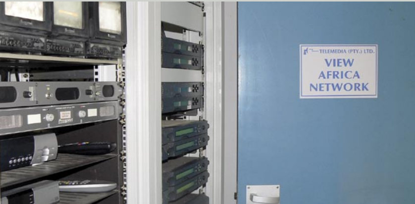
▲ Hier befindet sich das Herz des Programm-Pakets View Africa: im linken Schrank befinden sich Monitore und Receiver für den Empfang, im rechten Schrank sieht man die Encodereinschübe für die verschiedenen Programme. Die Einspeisung erfolgt bei vielen Programmen aus den Studios, die nur ein paar Meter entfernt sind.
