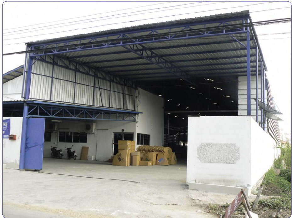
Das Fabrikationsgelände des Spiegelherstellers INFOSAT in Bangkok. Das blaue Rolltor ist normalerweise geschlossen und wird von einem ständig anwesenden Wächter bedient.
