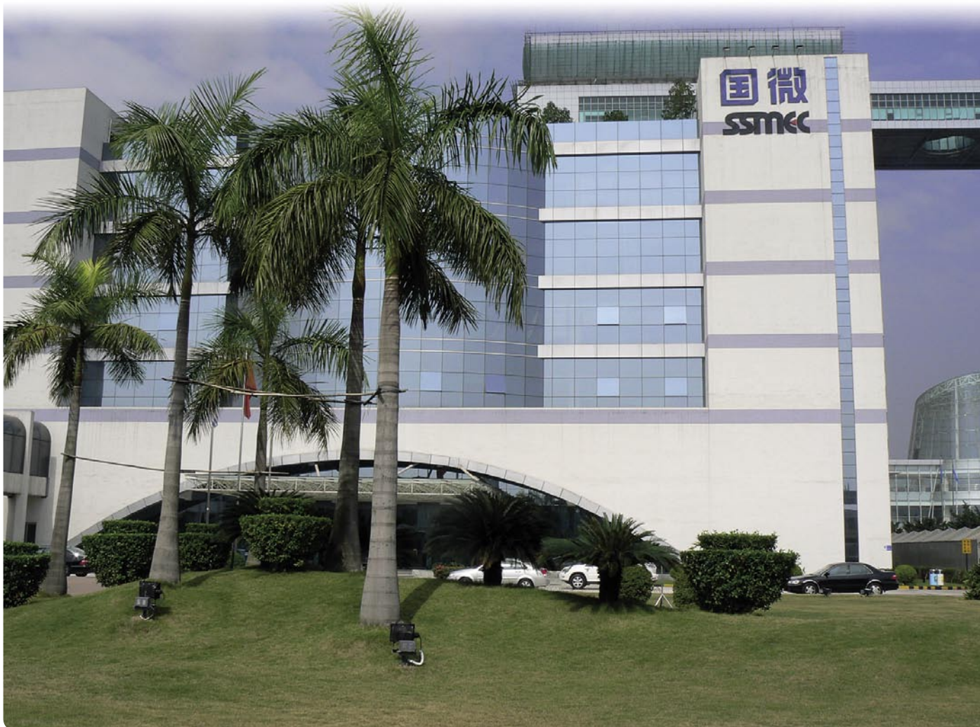
Palmen auf dem Firmenareal, der Pazifik ist schließlich nicht weit: das SSMEC Building in NanShan/ShenZhen. SSMEV ist einer der Anteilseigner von SMiT.
