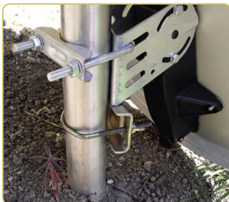
Hilfsweise Montage einer Schelle unterhalb der Antennehalterung
