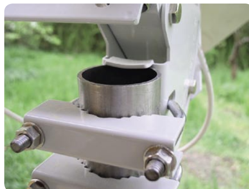
Montage des EDON-Actuators an der Mastspitze
