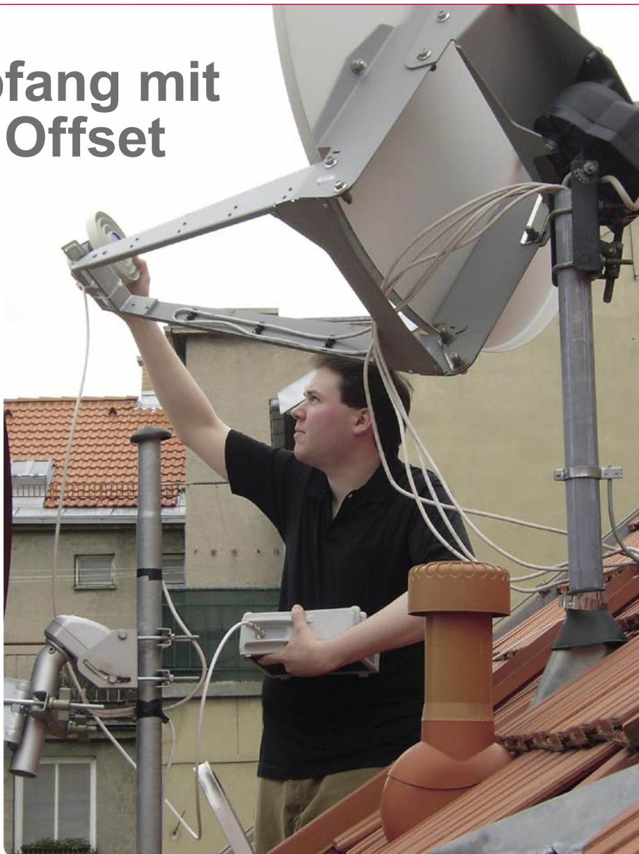
Thomas Haring justiert mit der rechten Hand ein C-Band-Feed an einer 1.2m Offset Antenne, und korrigiert die Stellung des Feeds mit Hilfe des PRODIG-5 Meßgeräts, das an anderer Stelle in dieser TELE-satellit Ausgabe vorgestellt wird, und hier gleich seine Praxistauglichkeit zeigt. |
