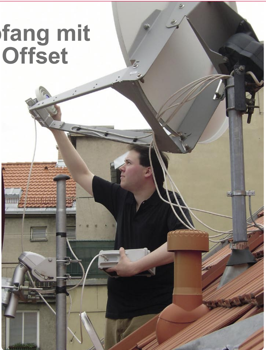
Thomas Haring justiert mit der rechten Hand ein C-Band-Feed an einer 1.2m Offset Antenne, und korrigiert die Stellung des Feeds mit Hilfe des PRODIG-5 Meßgeräts, das an anderer Stelle in dieser TELE-satellit Ausgabe vorgestellt wird, und hier gleich seine Praxistauglichkeit zeigt. |
